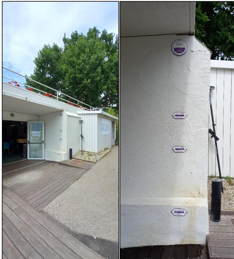
Macarons sur le restaurant du Lido à Tresserve
